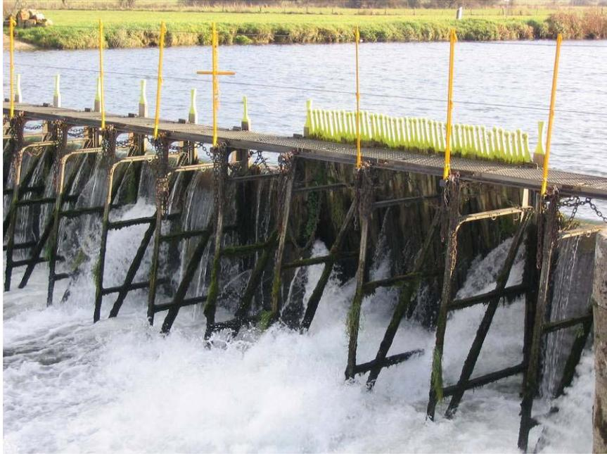
*Figure 2.7 Barrage à aiguilles de Villers-devant-Mouzon*
