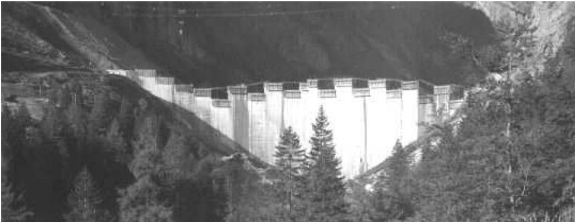
Figure 9-8 Barrage construit par plots successifs [2]
