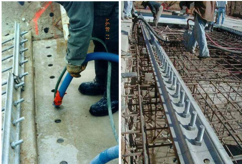
*Figure 2.39 Installation sur une fondation existante ou sur une nouvelle fondation<sup>1</sup>*
