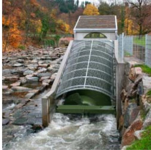
Figure 5.8 Microcentrale à vis sans fin<sup>3</sup>
