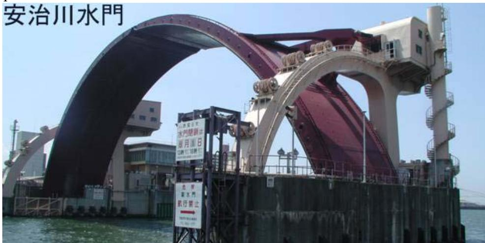
Figure 3.3 Barrière en arc de la rivière Aji Osaka, Japon, 1970
