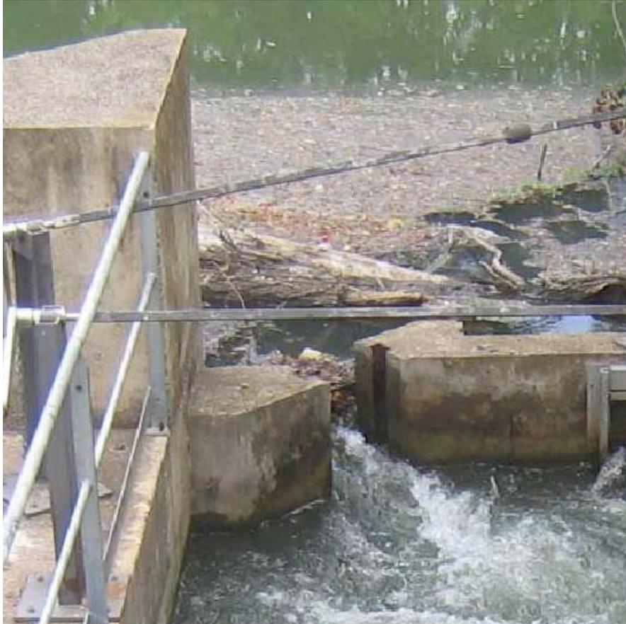
**Figure 4.13 Colmatage de la prise d'eau [3]**
