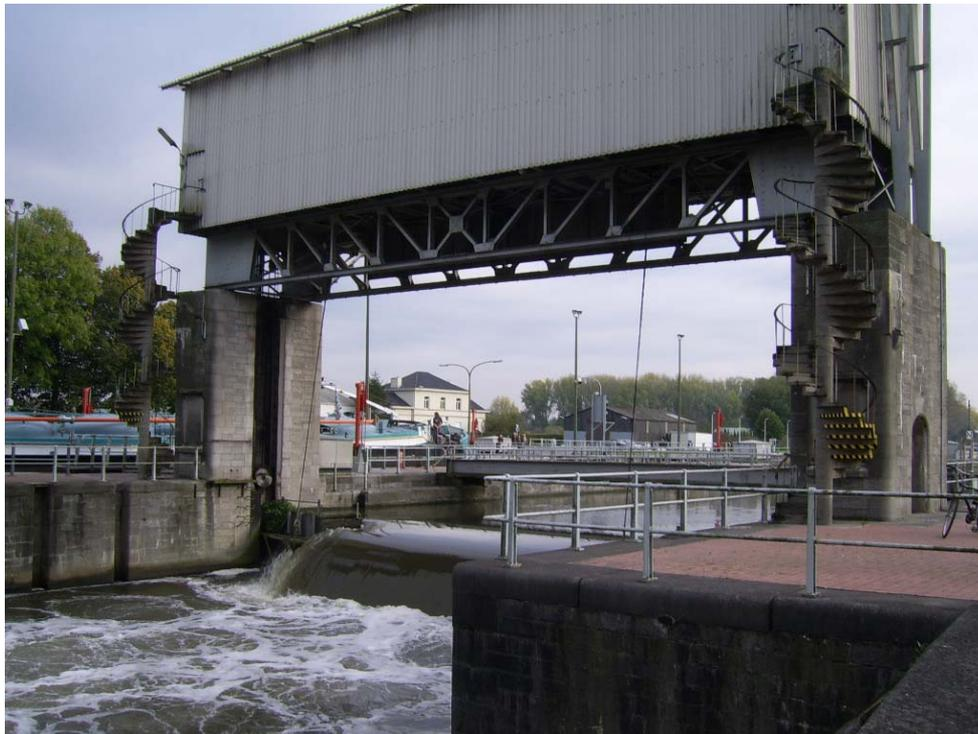
*Figure 2.19 Vanne levante avec hausse (barrage de Kain)*
