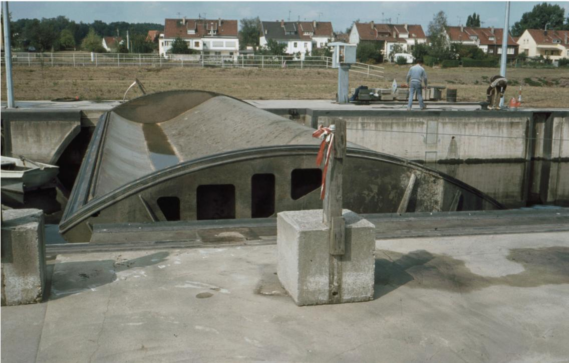
Figure 6.47 Vanne segment (Allemagne)
